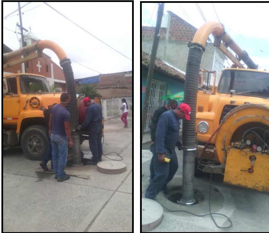
Mantenimiento de Redes de Alcantarillado con equipo de lavado, presión, succión en El Cabuyal
