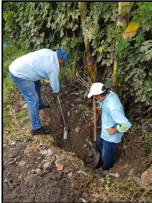
Búsqueda de la tubería
