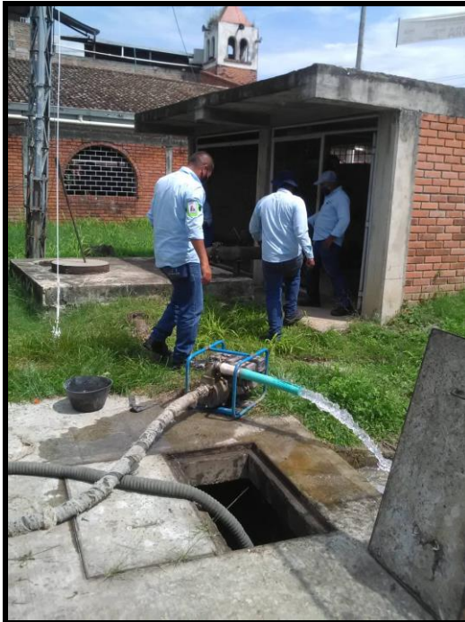
Mantenimiento preventivo del tanque de agua en el rebombeo del corregimiento de san Joaquín
