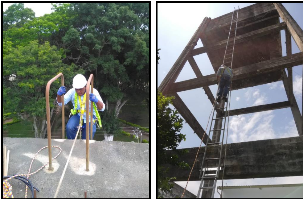
Mantenimiento preventivo del tanque de agua del corregimiento de El Tiple
