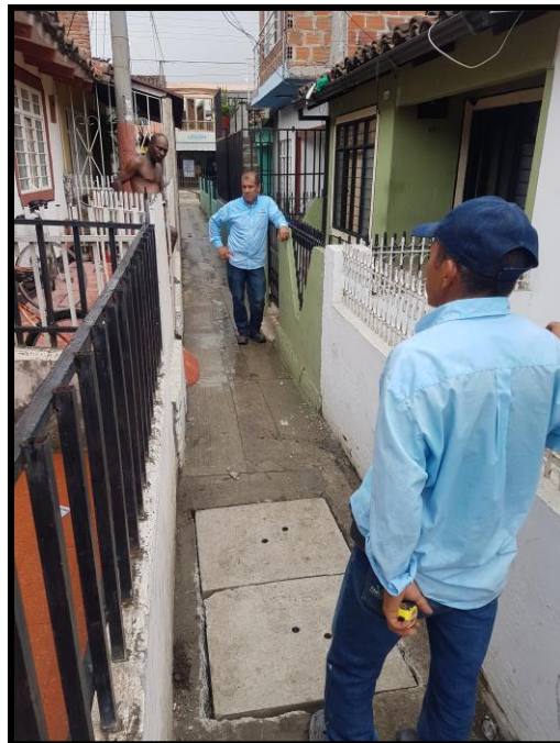
Reposición de tapa de alcantarillado en la calle 15ª entre carreras 14 y 13 Villagorgona
