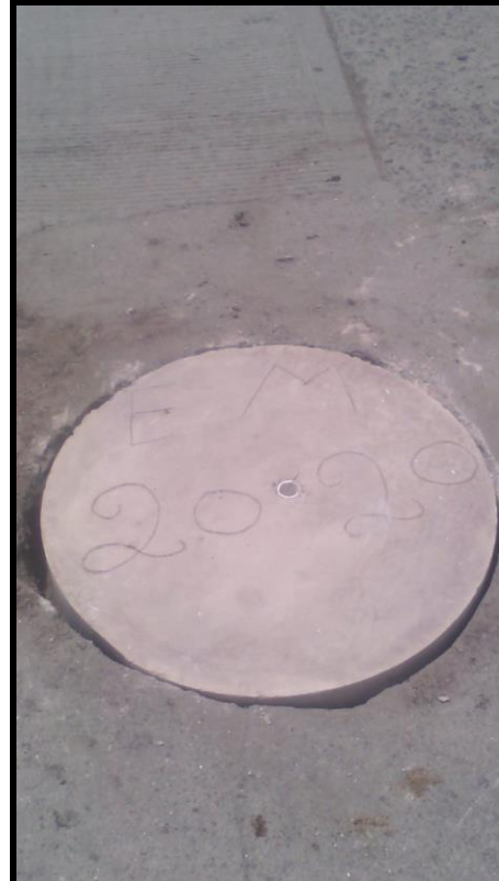
Reposición de tapa de alcantarillado en la carrera 5 con calle 6 El Cabuyal
