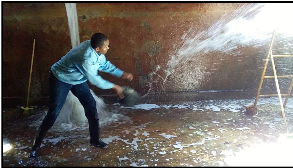
Mantenimiento preventivo del tanque de agua del corregimiento de Cabuyal
