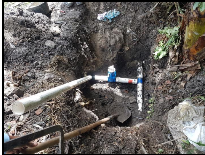
Instalación de Válvula para purga de Red
