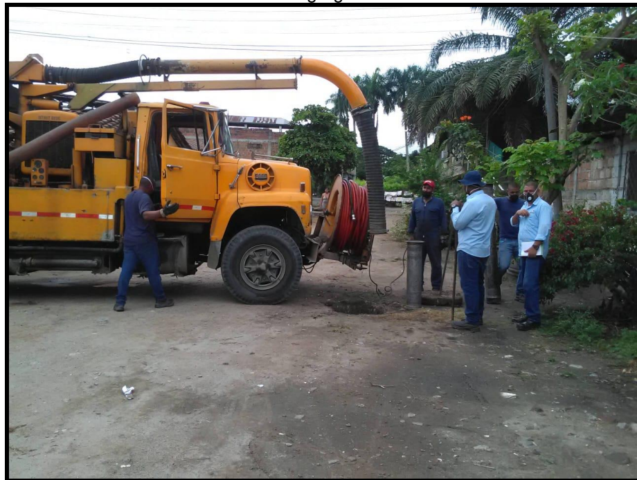
Mantenimiento de Redes de Alcantarillado con equipo de lavado, presión, succión en El Carmelo
