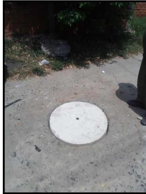
Reposición de tapa de alcantarillado en la carrera 1 entre calles 14 y 15 Villagorgona
