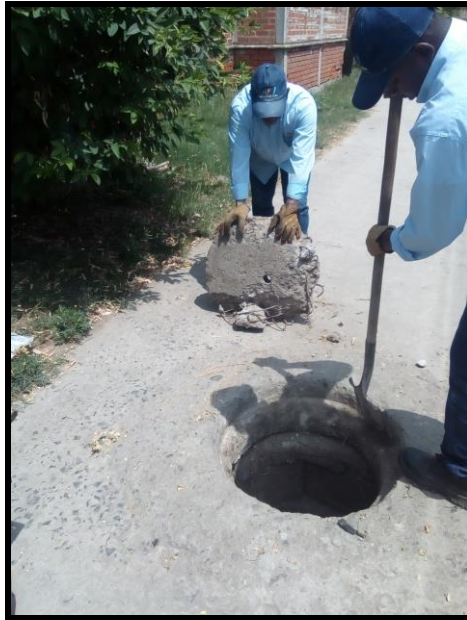
Reposición de tapa de alcantarillado en la carrera 1 entre calles 14 y 15 Villagorgona
