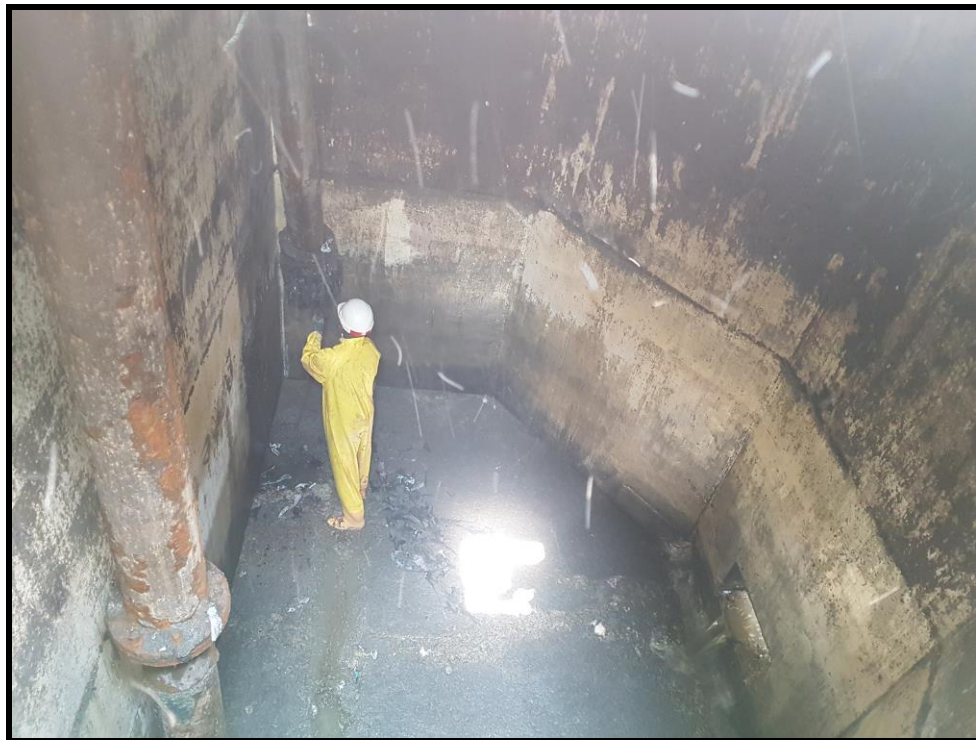
Mantenimiento preventivo y correctivo de la EBAR La Victoria Villagorgona.
