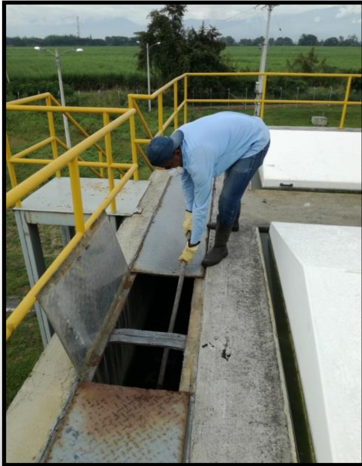
MANTENIMIENTO PREVENTIVO DE CANALES DEL UASB
