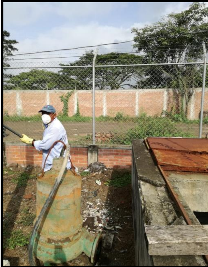
MANTENIMIENTO PREVENTIVO Y CORRECTIVO DE LA BOMBA SUMERGIBLE DE LA EBALL
