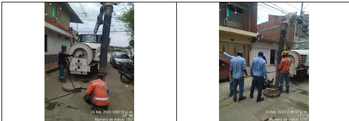
Mantenimiento preventivo con equipo de succión presión en la EBAR La Victoria Corregimiento de Villagorgona
