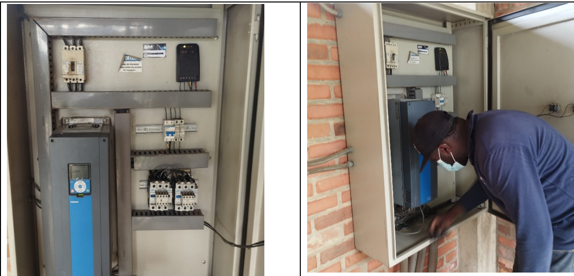
Mantenimiento preventivo en la estación de bombeo de la Regina, limpieza en tablero eléctrico y ajuste de tornillos.
