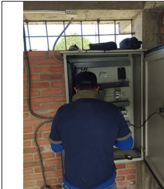
Mantenimiento a la estructura de Macromedidores ubicados en el Callejón San Jose y El Carmelo.
